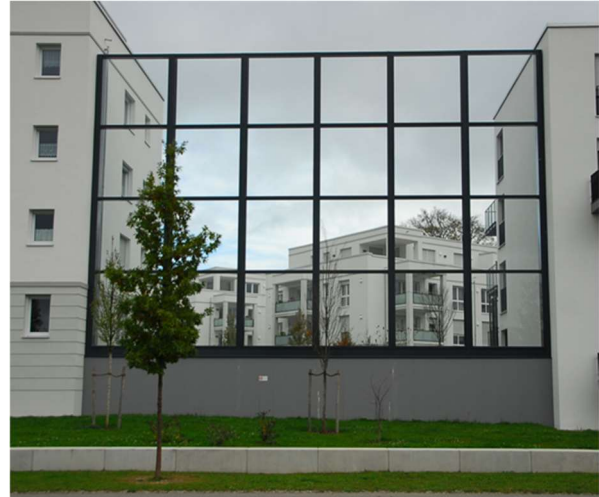
Abb. 12: Hohe transparente Trenn- und Lärmschutzwand an einem Gebäudekomplex. Vogelerschlag ist hier wiederholt nachgewiesen (B.-U. Rudolph)
