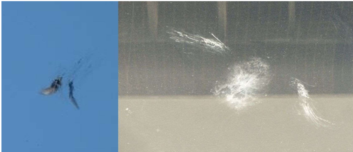
Abb. 2: Neben der Kadaversuche lassen sich Vogelkollisionen vor allem über die Spurensuche an Fassaden nachweisen. Links ist eine Kleinfeder als Anflugspur an einer stark spiegelnden Fassade und rechts der Gefiederabdruck in typischer Ausprägung mit Körper und Flügeln zu erkennen (K. Steiof).
