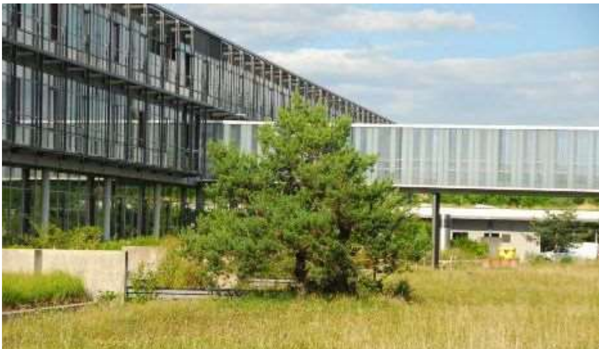
Abb. 21: Übergang zwischen zwei Flügeln eines Verwaltungsgebäudes mit vogelsicheren, mattierten Scheiben (B.-U. Rudolph)
